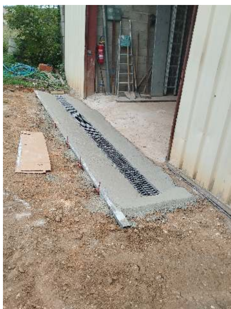
Mise hors d'eau du hangar communal
