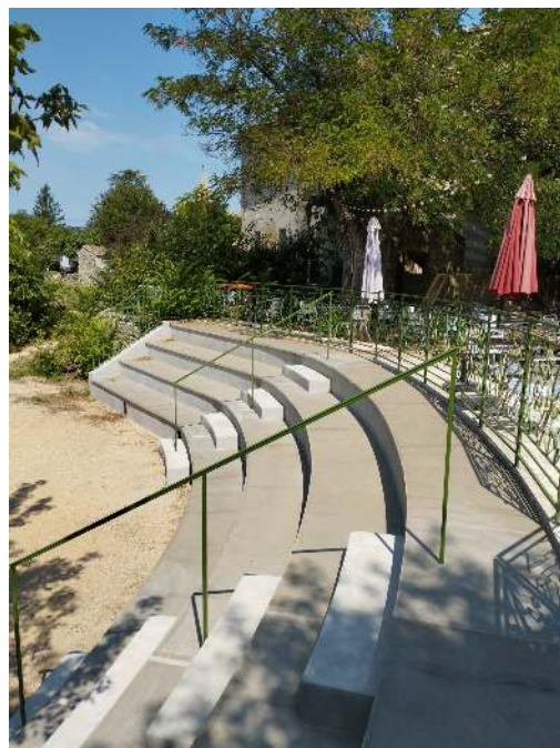
Réhabilitation de l'amphithéâtre et création de rampes
