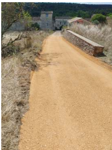
Grand Rue pendant réfection
