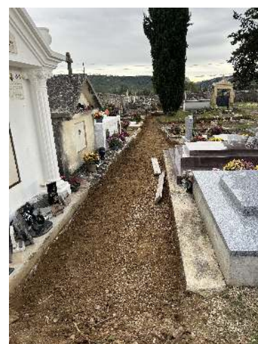
Travaux en cours
